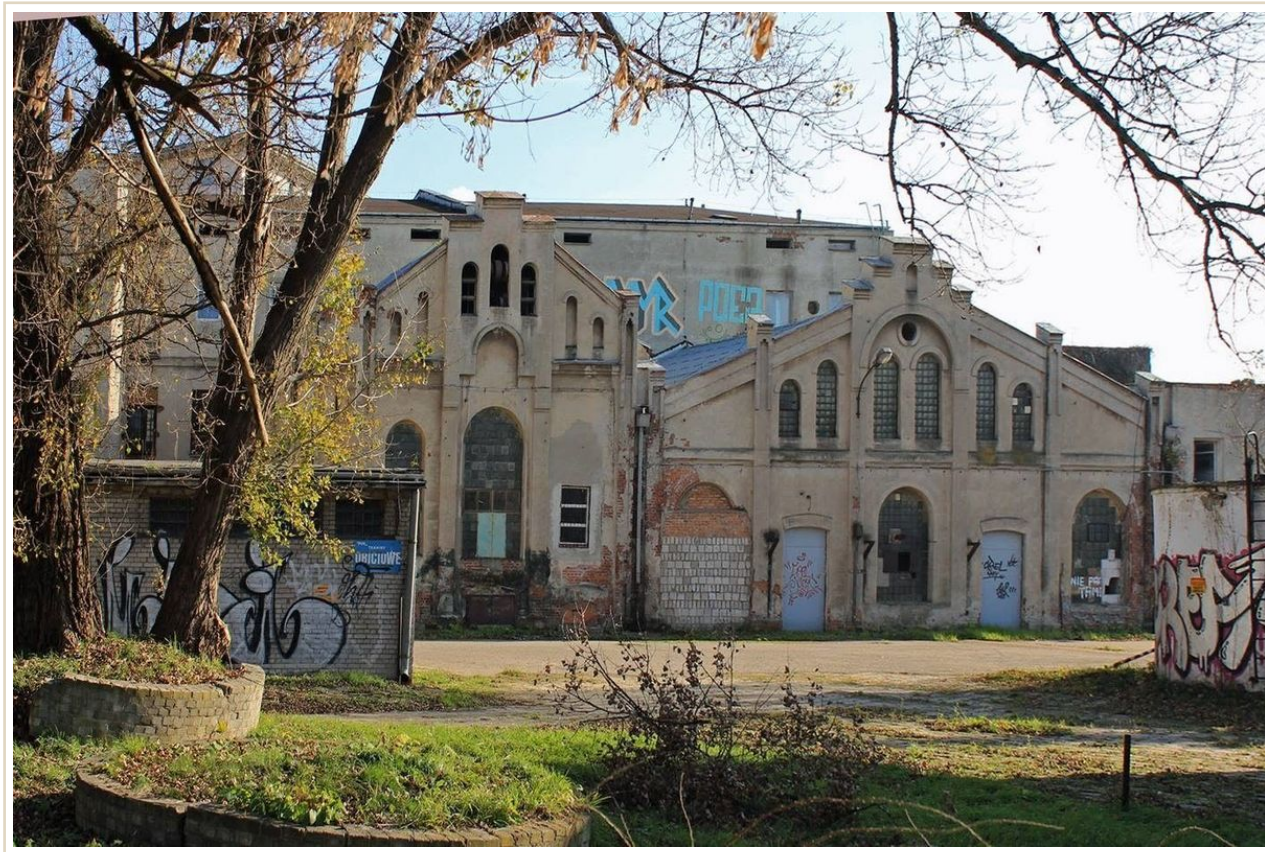
Ruiny garbarni „Temler i Szwede” przy Okopowej 78 — stan współczesny; obiekt wpisany do rejestru zabytków
