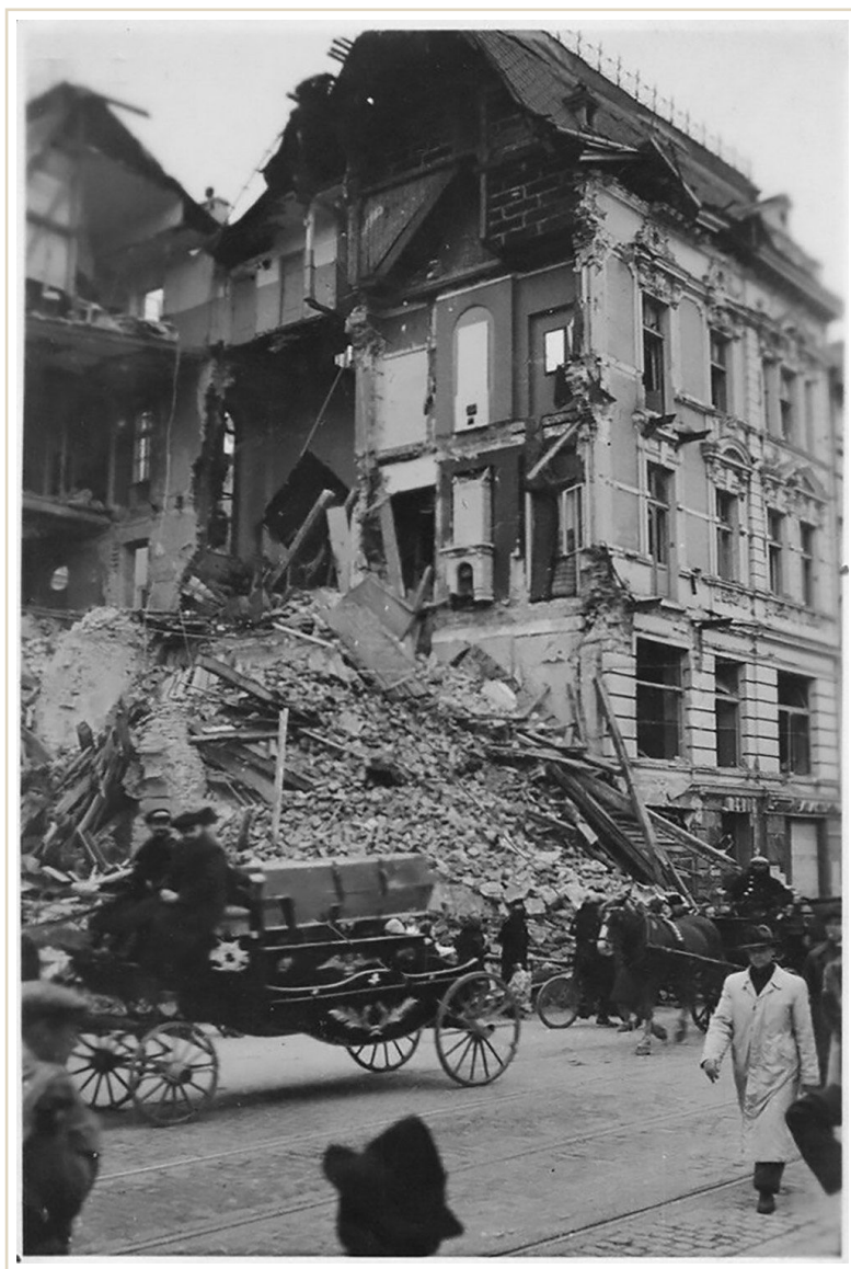
Po odgruzowaniu jezdni: dorożka i wóz konny mijają wypatroszony narożnik, przechodzień w jasnym płaszczu, w głębi resztki parteru ze sklepem. Przełom 1939 i 1940 roku. fotopolska.eu.
