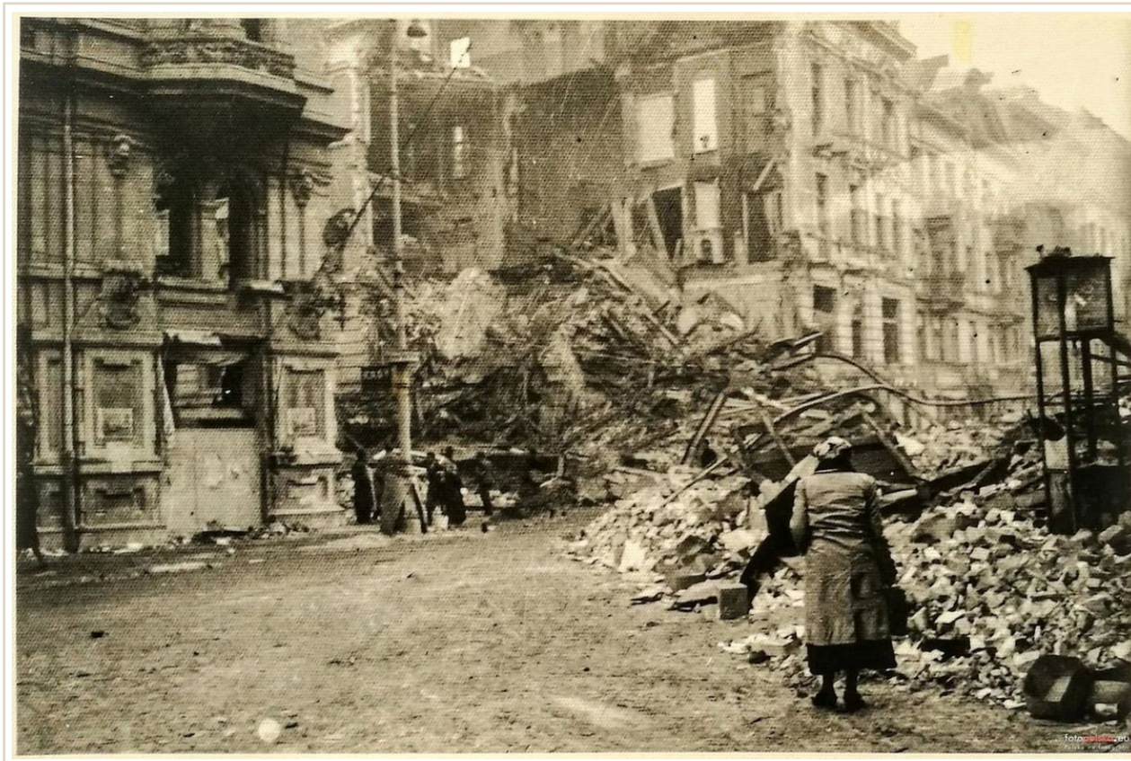
Nowy Świat od strony Foksal, jesień 1939, przed odgruzowaniem: zwały cegieł i belek sięgają środka jezdni, kobieta w płaszczu wspina się po gruzie; po lewej ocalała część kamienicy, w głębi wypatroszony narożnik. fotopolska.eu.
